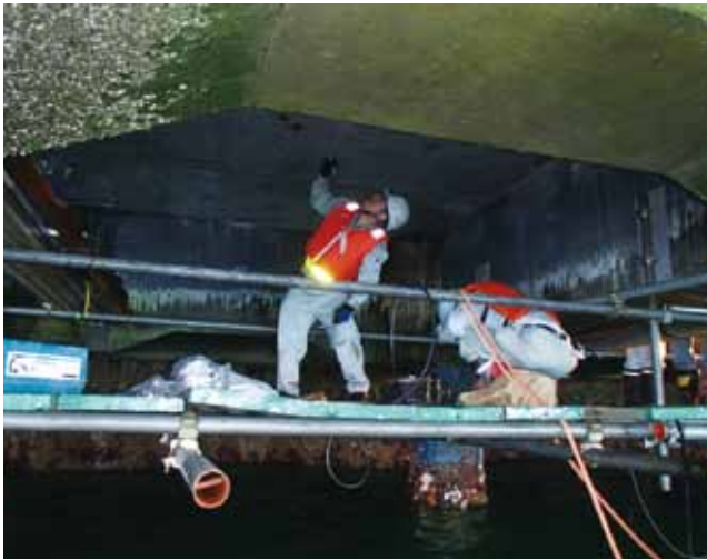
写真2 吊り足場からの近接目視調査
