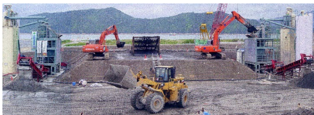
浚渫土の改良
