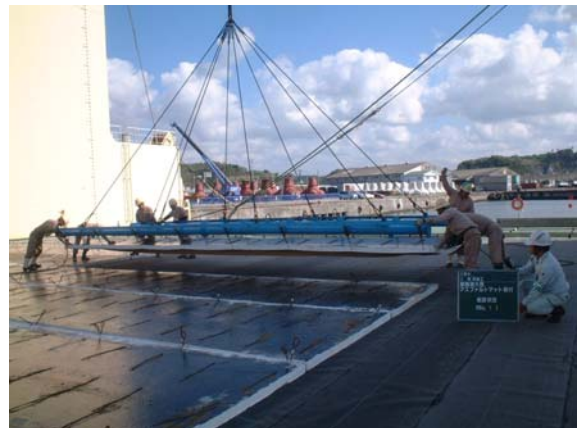
写真-1 敷設状況
