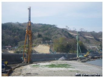
写真-3 陸上施工の事例(岩手県)
