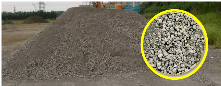
写真-1 エコガイアストーン(施工前)
