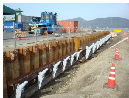
写真-2 EHD アンカー施工例
