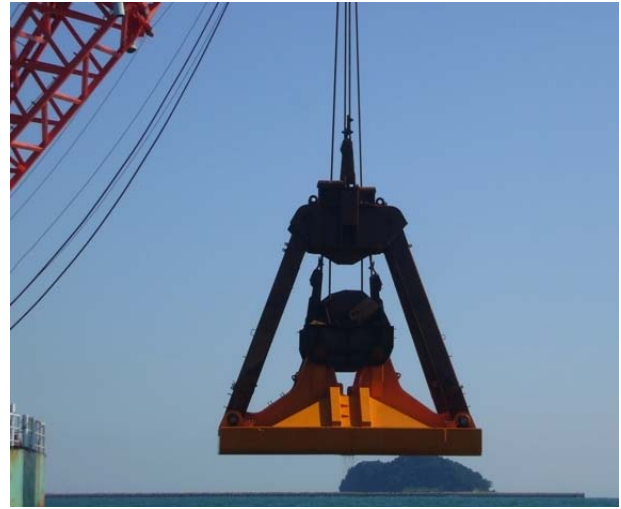
写真-2 掘削刃先の様子（密閉時）
