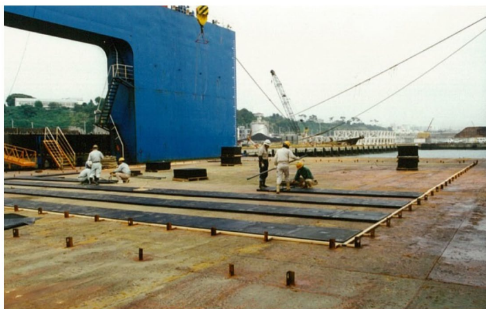
写真-1 ラフト敷き
