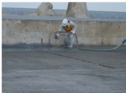
写真-2 S Q S 吹付状況
