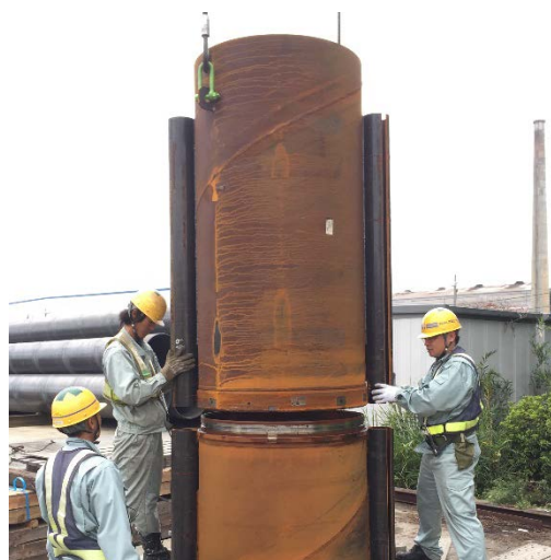
写真 1 ラクニカンジョイント (ステップ型)の施工状況
