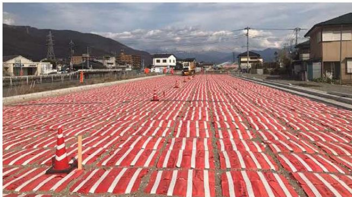
甲府市内のバイパス工事での路盤補強と振動対策（水）2017年3月
