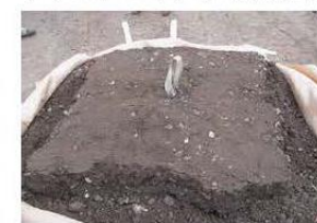
吊上後の中詰状況
