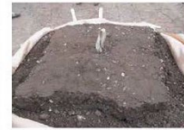
吊上後の中詰状況
