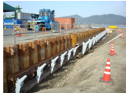
写真-2 EHDアンカー施工例
