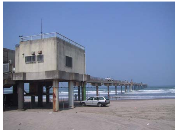
写真-1 観測棧橋
