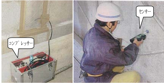
写真-4 ガス検知作業
