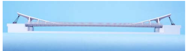
図-6 東側広場のデッキ概観 (フィンバックトラス橋)
