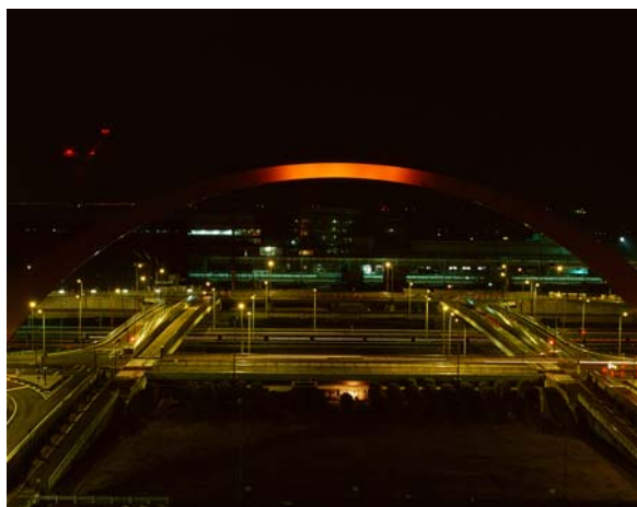
写真-4 スカイアーチ西側面（オレンジ）
