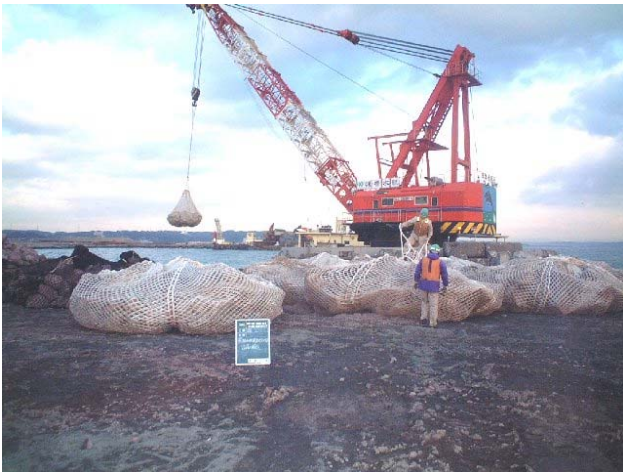
写真-2 運搬船への積み込み
