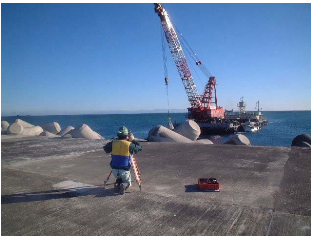
写真-3 誘導・据え付け
