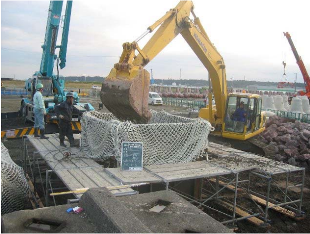
写真-1 型枠製作完了後の中詰め石投入
