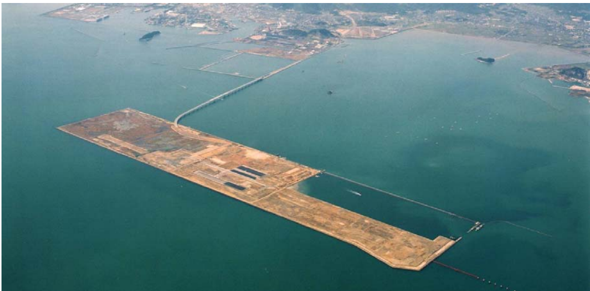
写真-1 新北九州空港建設状況 (H16.3)
