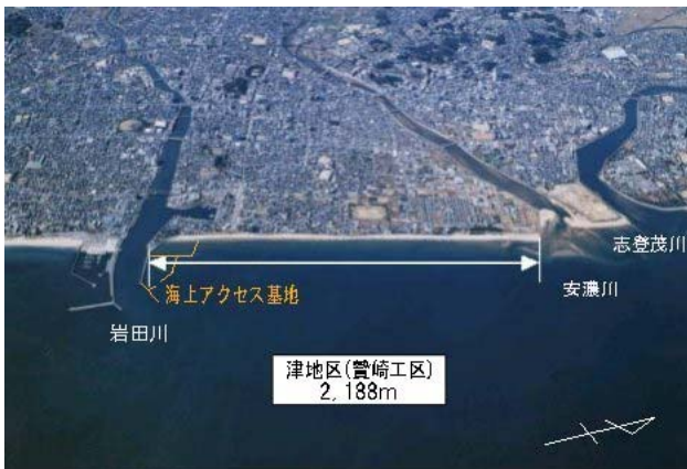
写真-1 贄崎海岸の全景
