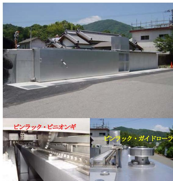
図-3 横引き式陸間の動力化例
