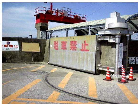
図-4 スイング式陸間の動力化例
