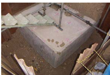
写真-2 A2 橋台底版部掘削状況
