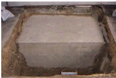
写真-1 A1 橋台底版部掘削状況
