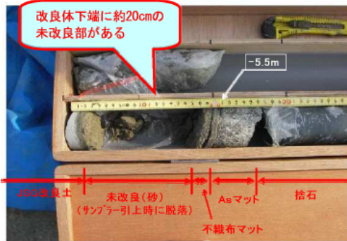
写真-3 改良体の未改良部分 (採取コア)
