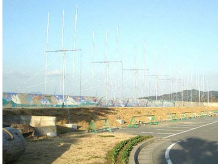
図-3 有明海 海洋短波レーダ局アンテナ (宇土局)
