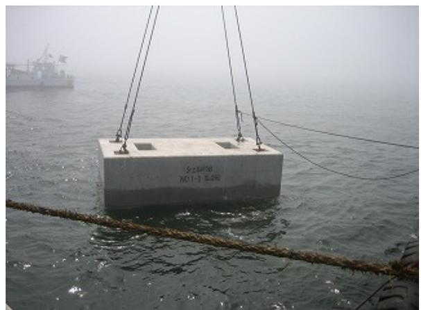
写真-3 根固ブロック海中投入状況
