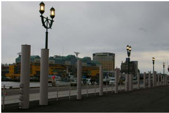
写真-1 津波漂流物対策施設（釧路港）
