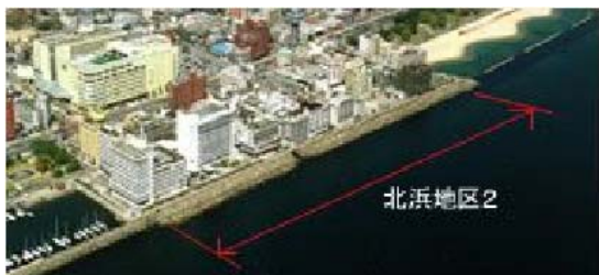
写真-5 北浜2地区の全景 1)
