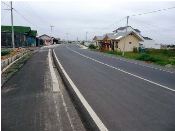
写真-5 日本の援助で建設された道路
