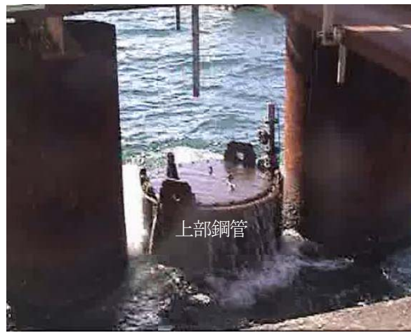
写真-3 浮上状態の上部鋼管
