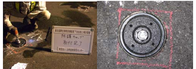
写真-2 提案型防護キャップ設置状況 (C1 誘導路)
