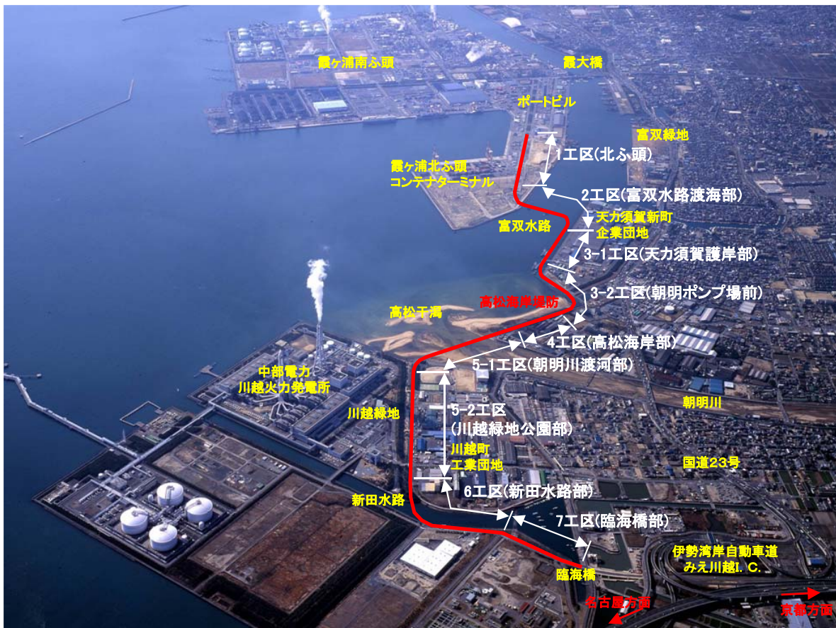
図-1 霞4号幹線の全景
