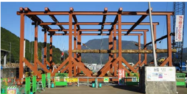
図-5 実験架台設置状況
