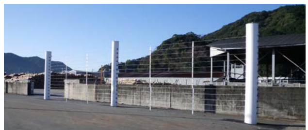
図-3 津波漂流物捕捉施設実験区間
