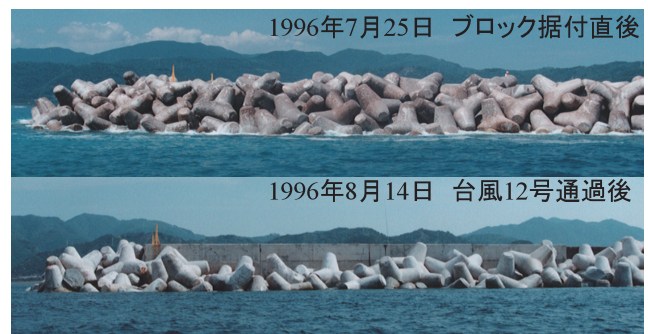
図-1 M港の被災事例
