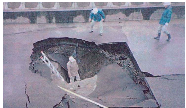
図-1 護岸部の吸出しによる影響
