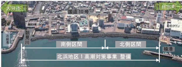
写真-2 北浜地区1護岸の全景
