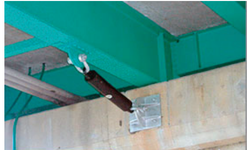
写真-2 落橋防止構造 (東北地方整備局 HP)
