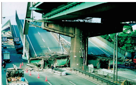
写真-1 阪神大震災による落橋被害 (国総研 HP)
