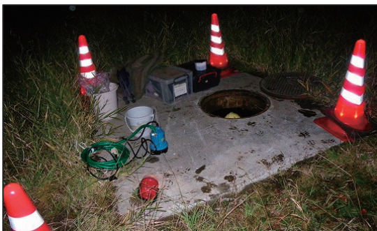
写真-1 現地踏査実施状況
