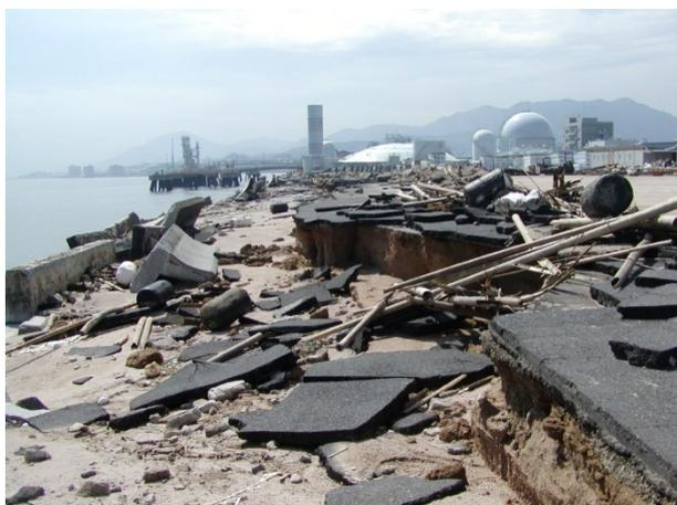
図-2 台風0418号による広島廿日市埋立護岸の崩壊
