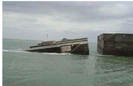
写真-1 台風に伴う高波・高潮による防波堤の被災状況
