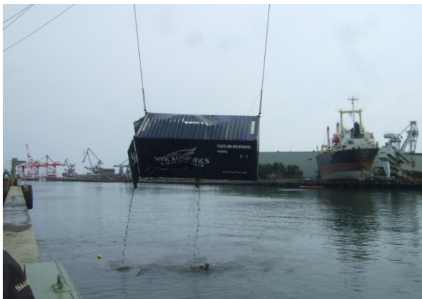
写真-2 障害物揚収作業(コンテナ)
