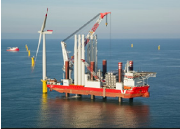
図-5 専用設置船 (出典: mpi-offshore.com ホームページ)
