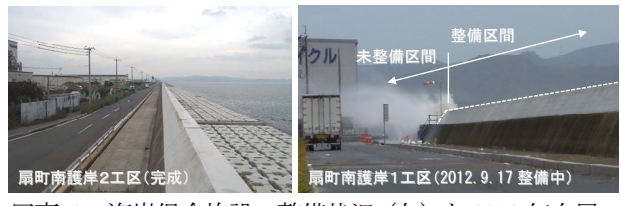
写真-2 海岸保全施設の整備状況（左）と2012年台風16号発生時の護岸の越波状況（右）（2012/9/17 11:03）
