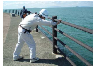
海岸保全施設の点検活動
