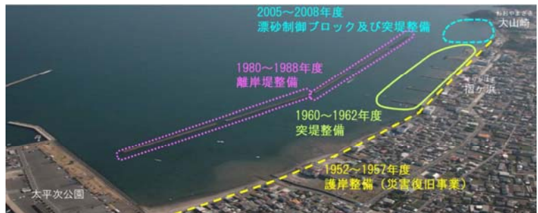
図-2 指宿港海岸整備地区（現況）
