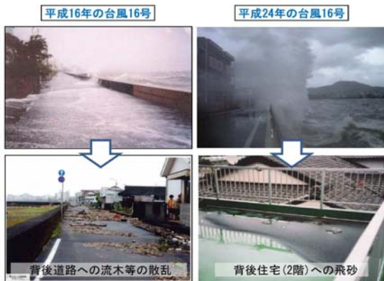
写真-1 越波の状況
