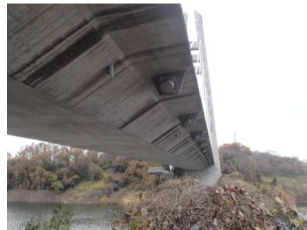
図-4 定着部が外側に設置された例
