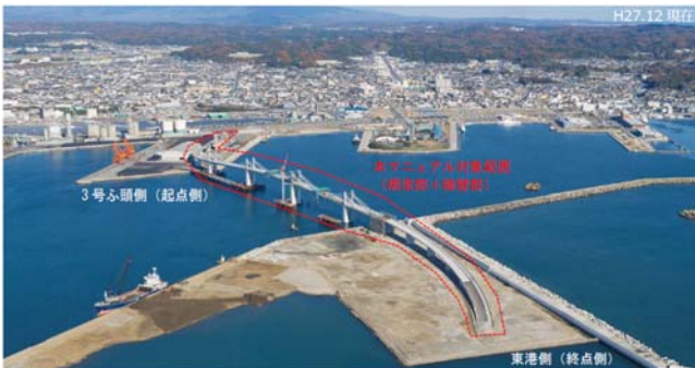
図-1 臨港道路の全景写真
