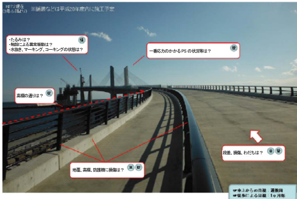
図-12 橋面上の点検ポイント
