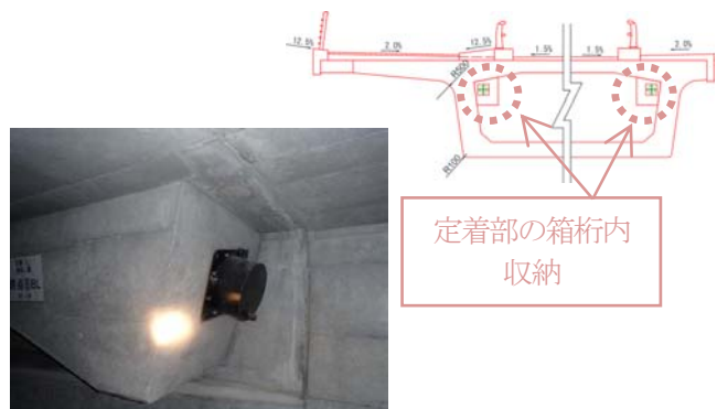
図-5 定着部を箱内に設置
