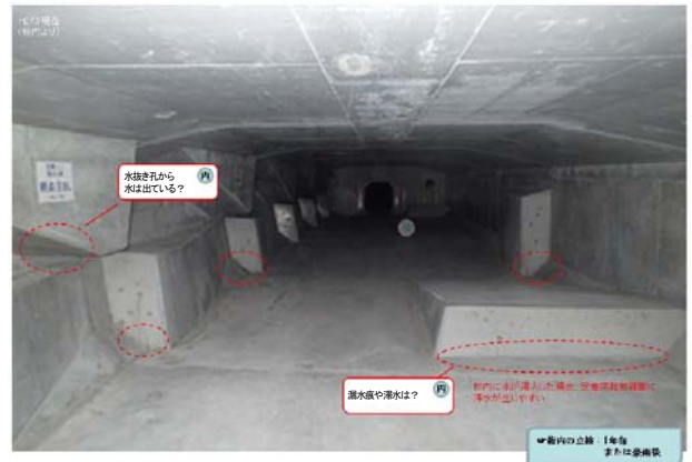
図-15 桁内の点検ポイント
