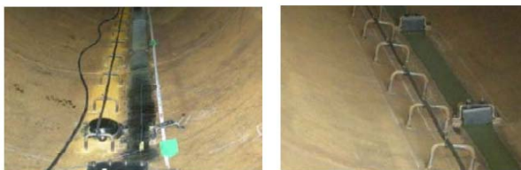
(初期緊張, 仮固定) (固定治具取り付け) 写真-1 BOTDR 初期緊張, 固定状況 2)
