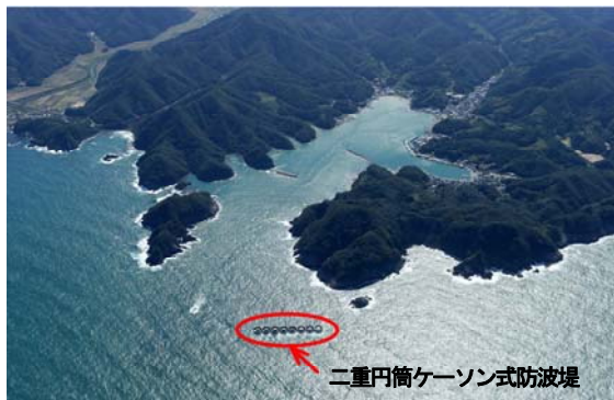
写真-1 二重円筒ケーソン式防波堤
