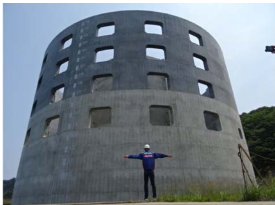
写真-3 二重円筒ケーソン構造の概要
