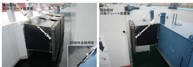
図-21 日除けカバー設置状況 (白島備蓄基地)
