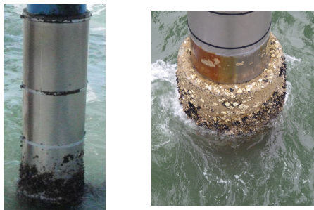
No. 16 チタンカバーモルタル被覆工法 No. 29 鉄筋コンクリート被覆工法(CRUS 工法)
