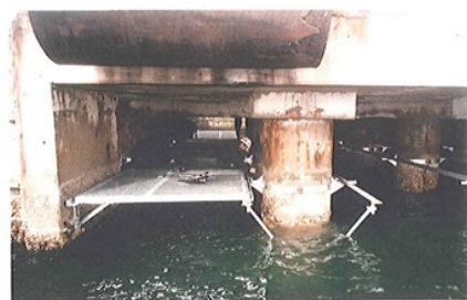
写真-3 ブラケット足場の例
