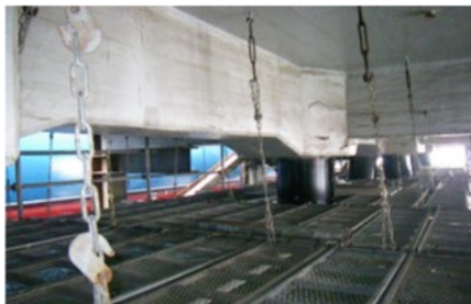
写真-2 吊足場の例
