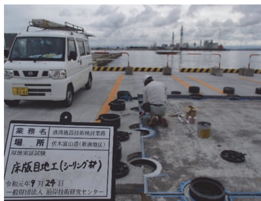
写真-7 目地板設置状況(シーリング材)
