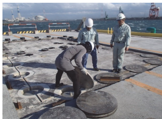
写真-8 鋼製蓋設置状況(舗装埋設型)
