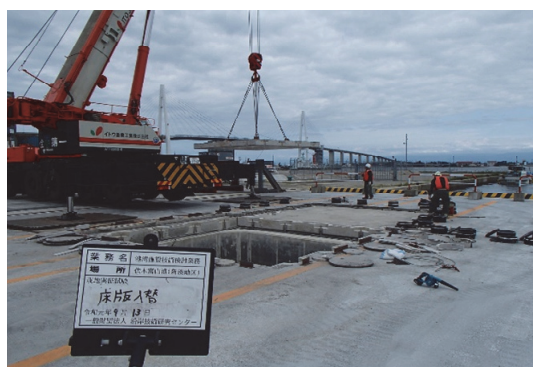
写真-5 床版入替状況
