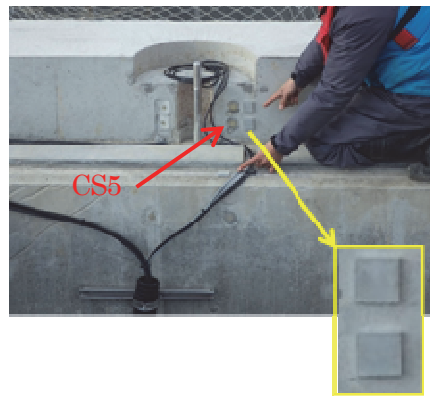
図-7 金属片, モルタルパネル等の設置状況
