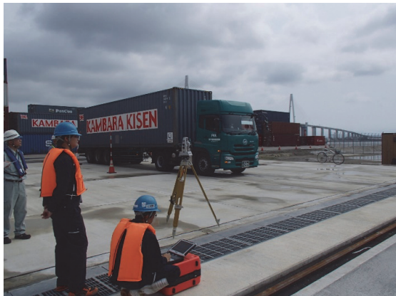
写真-4 計測状況(法線直角方向)
