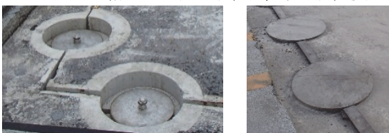
写真-1 箱型座金(左: 設置前, 右: 設置後)
