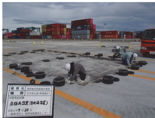
写真-6 目地板設置状況(箱型座金部)
