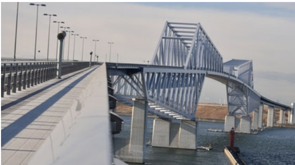
写真-1 東京ゲートブリッジ
